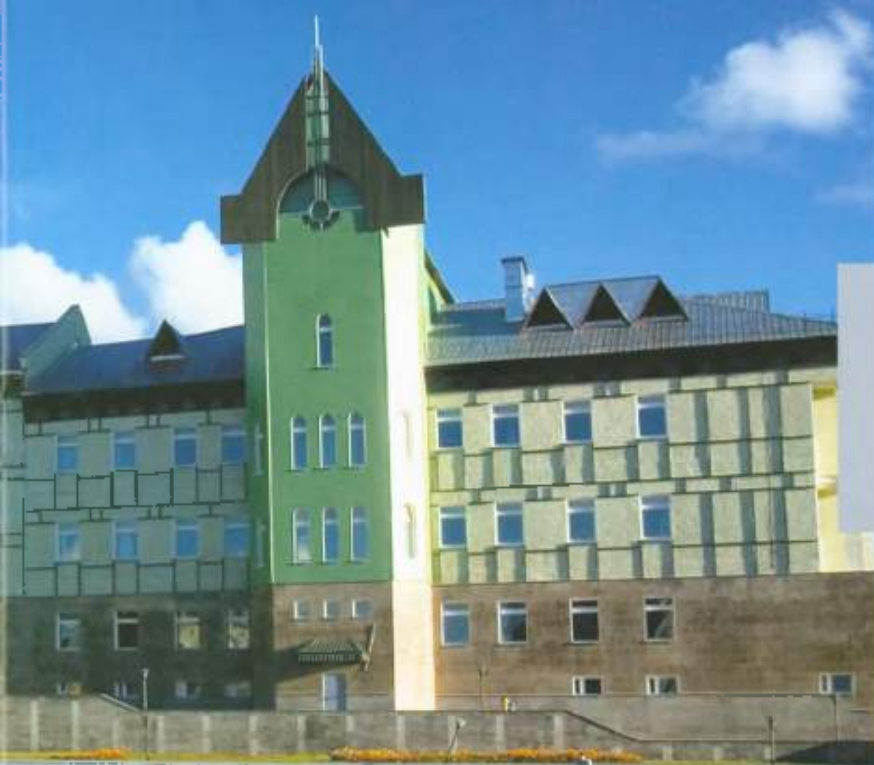
Санаторий - профилакторий ООО «Томен- трансгаз», спальный корпус санатория- профилактория
