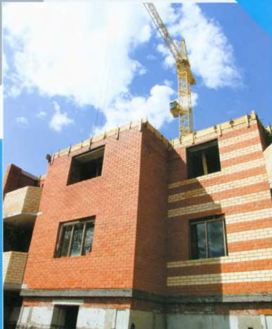
Строительство 56-квартирного жилого дома по ул. Бологов - Давыдова
