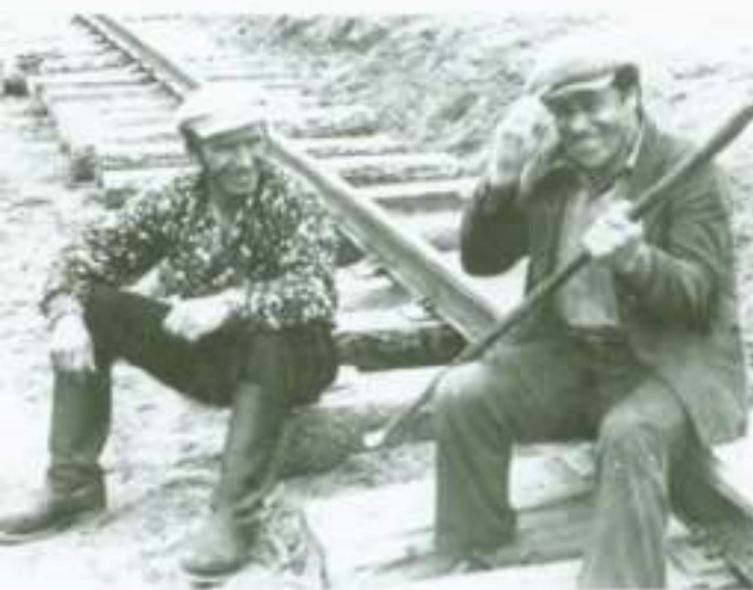
Ремонт подкрановых путей
