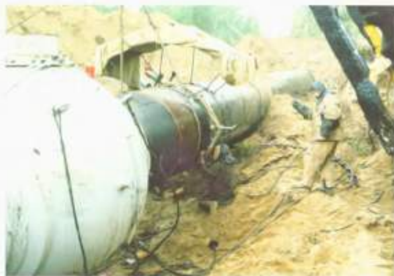
Сварочные работы на газопроводе
